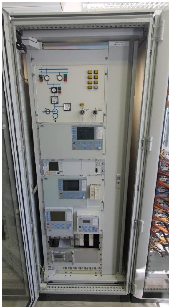
Slika 3-1: izgled omare vodenja, zaštite in meritev T131 – stanje po zamenjavi transformatorja
